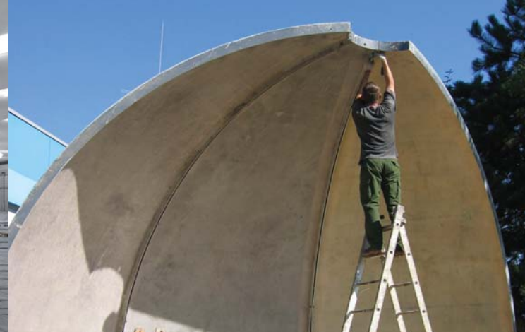
Vor-Ort-Montage einer Turmkuppel
